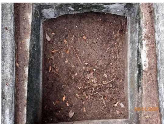
รูปที่ 2-11 บ่อดักตะกอนของรางระบายน้ำฝนที่ตกในพื้นที่ โรงแรม ก่อนระบายออกจากพื้นที่ (พื้นที่ปิดปรับปรุง)
